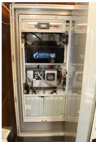
Основное оборудование автономной системы электроснабжения легко помещается в небольшой шкаф
